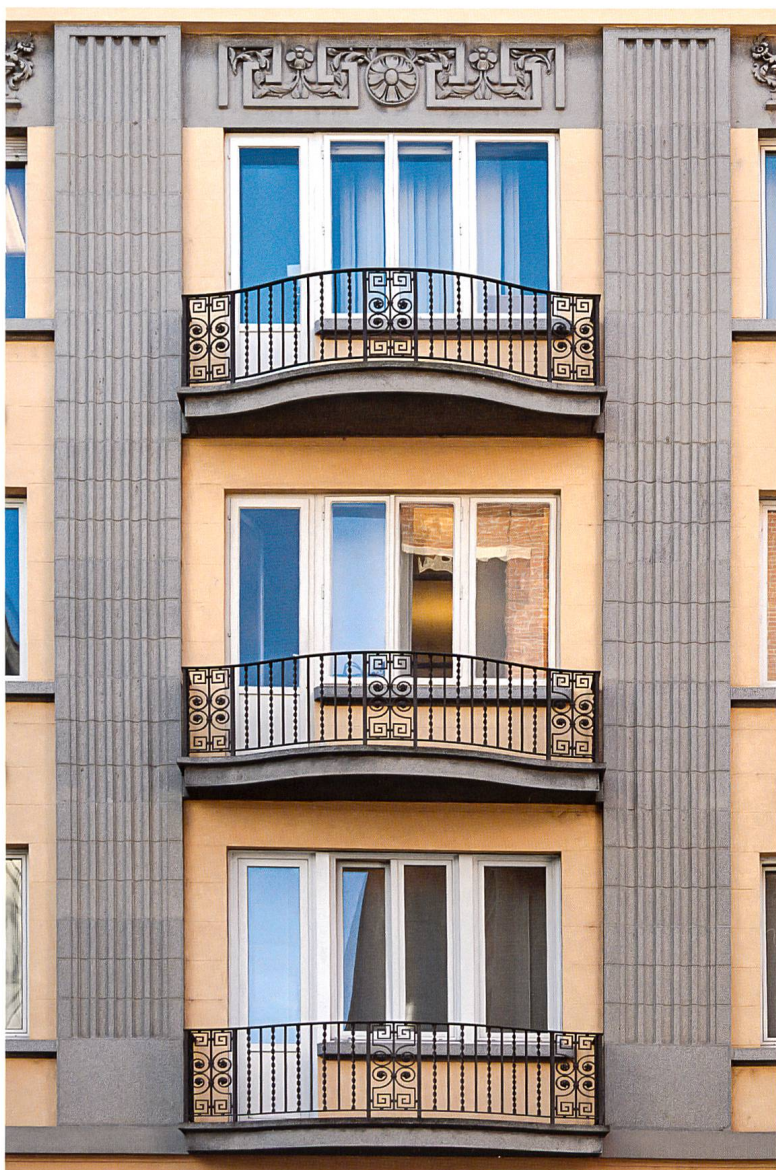
Ill. 1 Enea Tallone, Casa moderna, 1928. Particolare della facciata (Foto Michael Peuckert)
