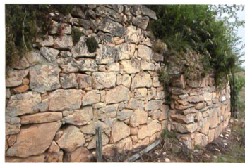
Fig. 18 Saint-Blaise, mur de pierre sèche à proximité des carrières. OPAN, 2012
