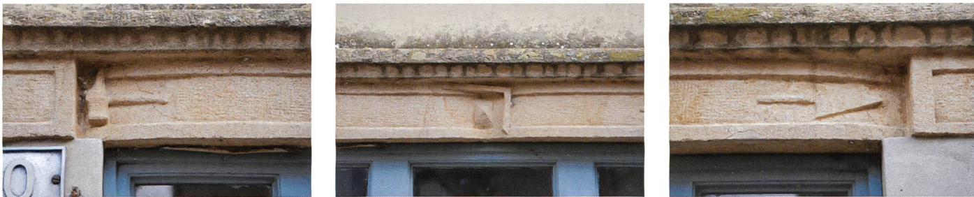
Fig. 10 à 12 Saint-Blaise, chemin de la Mureta 10. Outils du tailleur de pierre sculptés sur le linteau de porte. OPAN, 2009
