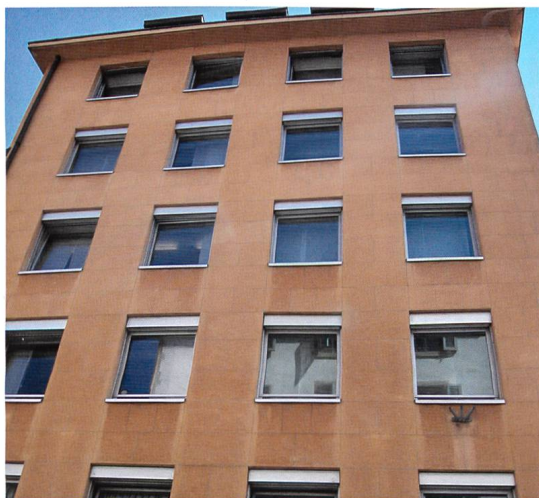
Fig. 9 Neuchâtel, rue de l'Hôpital 11, 1963. Placage en pierre de Jaumont. OPAN, 2012
