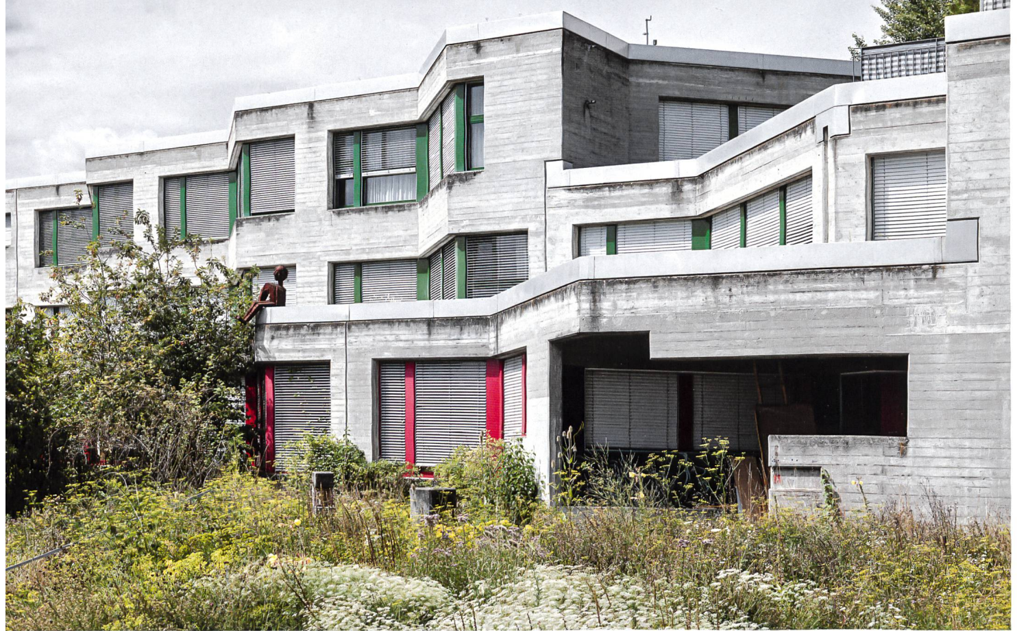
Schulhaus Im Gräfler in Schaffhausen-Herb- lingen, 1971–1974 von Förderer, Lüscher, Meier
