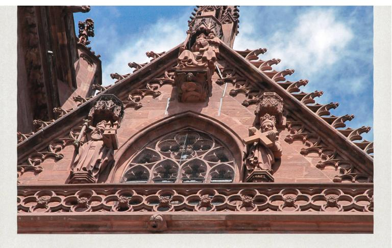
waren sehr schadhaft, es hatten sich zentimeterdicke Schalen abgelöst. Nur dank den periodischen Kontrollen und rechtzeitigem Eingreifen konnten wir in diesem Bereich noch schlimmere Schäden verhindern.
