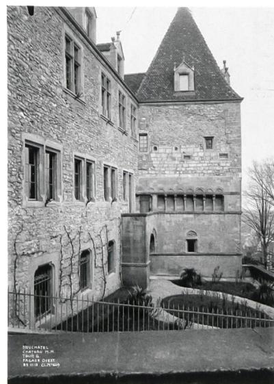
Fig. 12 L'aile romane après la restauration de Matthey (OPMSNE, 1913)
