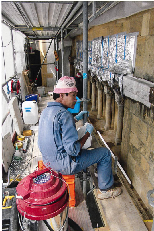
Fig. 17 Travaux de nettoyage en cours (photographie P. Jaggi, OPMSNE, 2009)
