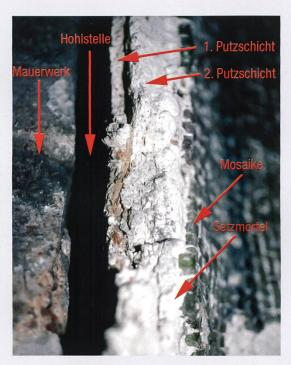
Schichtaufbau im Querschnitt
