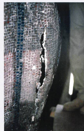
Aufgeplatzte, absteigende Mosaikoberfläche mit grosser Hohlstelle
