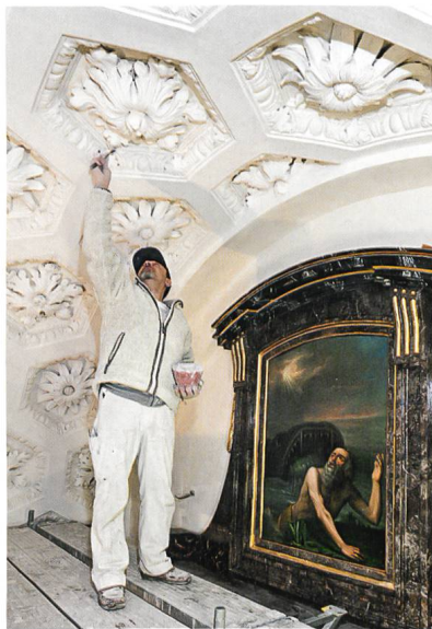
Kathedrale Solothurn , Reinigungsmuster: In einem ersten Schritt wurde der lose Staub mit einem Pinsel oder Spezialstaubsauger abgenommen (siehe zweitoberster Streifen), anschliessend die Stuckaturen mit Gummigranulat fein abgestrahlt und dann mit speziellen Reinigungsschwämmen trocken gereinigt. Dann erfolgte eine feuchte Nachreinigung (siehe ganz unten). Foto C. Fontana
