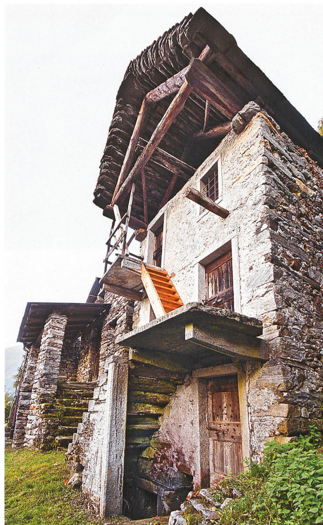
Sopra la cantina, di cui si indovina l'entrata, una vera e propria torre, con vani utilitari di diversa natura
