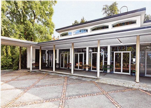
Abdankungshallen im Stil der Zeit: 1891 Unterer Friesenberg, Zürich. Architekten: Chiodera/Tschudy (rechts). 1952 Oberer Friesenberg, Zürich. Architekten: Parnes/Haefeli (unten)
