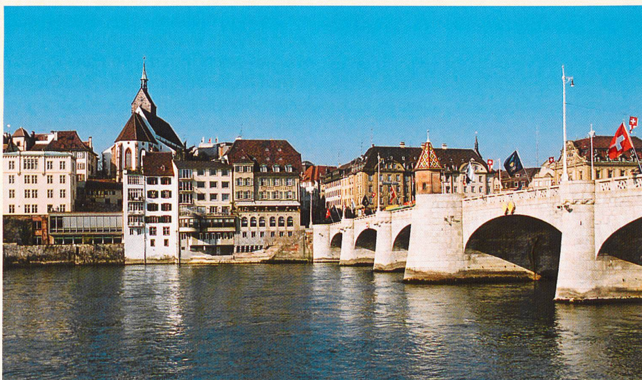
Mittlere Brücke in Basel, erbaut 1903–1905
