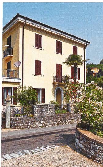
Casa d'abitazione fatta erigere nel 1875 dalla famiglia Carnevale, oriunda di Frugarolo (Piemonte, Provincia d'Alessandria), all'imbocco del paese. Facciata sud-est, verso il Piazzale San Rocco, costruito nel 1859
