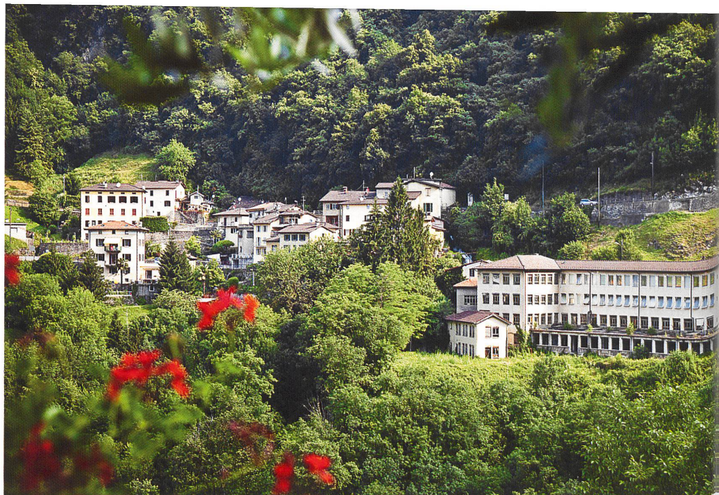
Veduta del lato sud delle Fabbriche con il corpo avanzato costruito nel 1951, dove furono installati i laboratori per la rifinitura di pezzi e la lavorazione di cerniere
