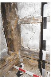
Abb. 8 Haus St.-Oswalds-Gasse 10, Erdgeschoss, Südwand: Auf dem originalen Mittelständer liegt der Unterzug auf. Die vertikale Nut im Ständer und das Kopfholz auf der Ständeraussenseite sind noch vorhanden. Sekundär sind der Steinsockel und das Fundament unter dem Ständer sowie die von aussen an den Bohlen-Ständerbau gemauerte Steinwand, in der horizontale Negative von Wandbohlen sichtbar sind
