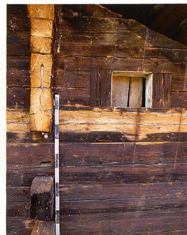
Abb. 2 Haus Unterblacki, Ansicht an das Giebfeld der noch nicht renovierten Hauptfassade: Unter dem originalen Heiterloch ist der Fenstergurtbalken mit farbigem Negativ eines abgebeitlen Zierfrieses erkennbar. Durch das Zurücksägen der Vorstösse der Firstkammerwand wurde ein Dübel wieder sichtbar
