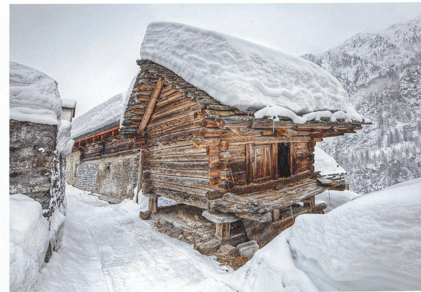
Cimalmotto (Comune di Campo Valle Maggia), 1404 m s/m. Questi piccoli granai su pilastri a forma di fungo sono rappresentativi di molte «torbe» valmaggese
