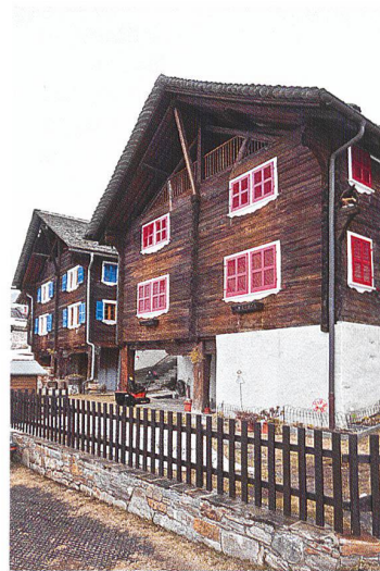
Rossura (Comune di Faido), 1055 m s/m In queste due dimore doppie di Rossura la struttura lignea a castello è sostenuta da tre grossi pilastri di legno. Entrambi i sottotetti sono aperti e presentano un colmo molto sporgente
