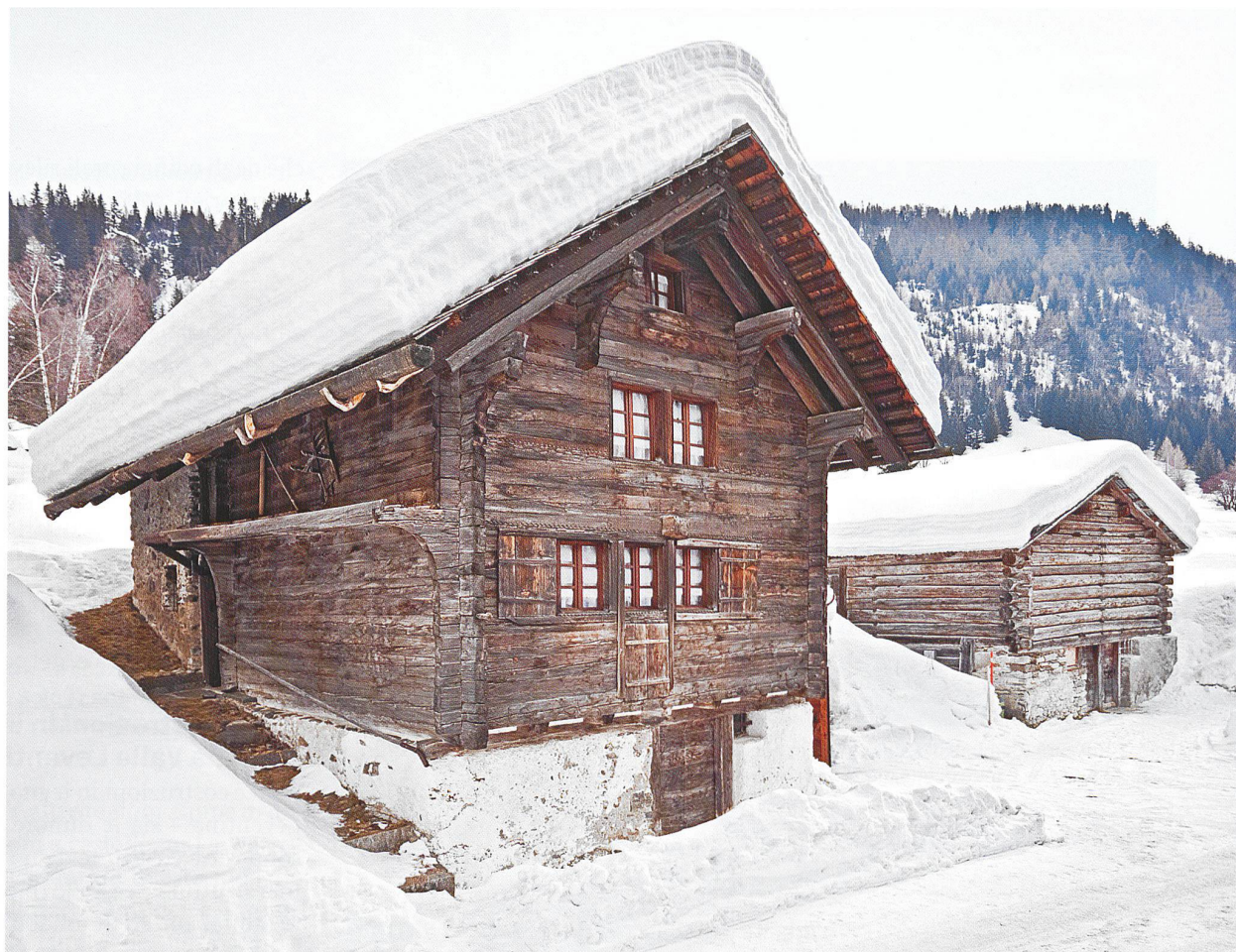
Ossasco (Comune di Bedretto), 1313 m s/m Questo raro esempio di dimora leventinese semplice è ancora munita degli originali scuri a scivolo e ricoperta da scandole di legno. Sulla trave longitudinale che sostiene il soffitto della «stüva» è incisa l'iscrizione: MELCHIOR ORELL BALDISARO NORELO STATA FATA FARE DA LOR FRATELI IM JAHR 1759
