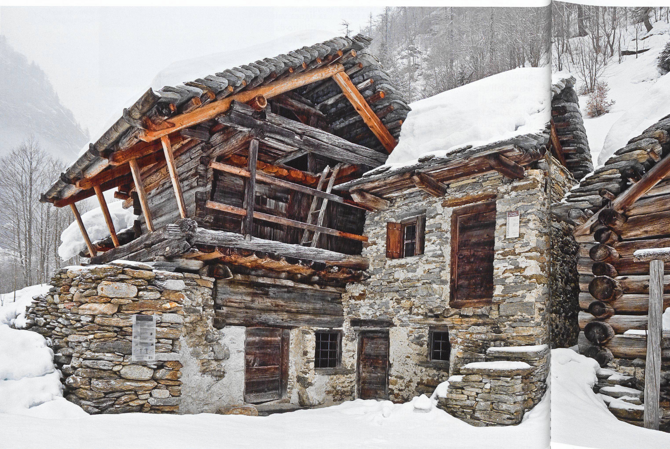
Cambleo (Comune di Lavizzara), 1120 m s/m. Questa «torbe» del 1401 è la più antica di tutta la Valle Maggia ed è l'unico esempio di granaio appoggiato su di una struttura a castello tramite una mensola perimetrale costituita da grosse assi. Nel 2003 il complesso dei due edifici qui riprodotti è stato restaurato e reso accessibile al pubblico per iniziativa dell'APAV
