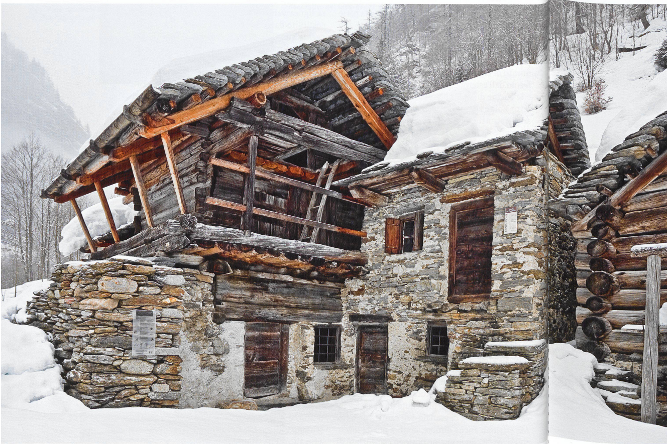
Camblo (Comune di Lavizzara), 1120 m s/m. Questa «torba» del 1401 è la più antica di tutta la Valle Maggia ed è l'unico esempio di granaio appoggiato su di una struttura a castello tramite una mensola perimetrale costituita da grosse assi. Nel 2003 il complesso dei due edifici qui riprodotti è stato restaurato e reso accessibile al pubblico per iniziativa dell'APAV
