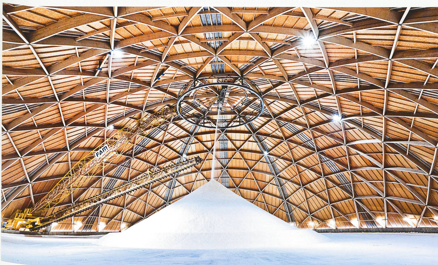
Salzlager des Saldome: das Tragwerk besteht aus drei sich durchdringenden Bogensystemen, die eine Holznetzschale bilden
