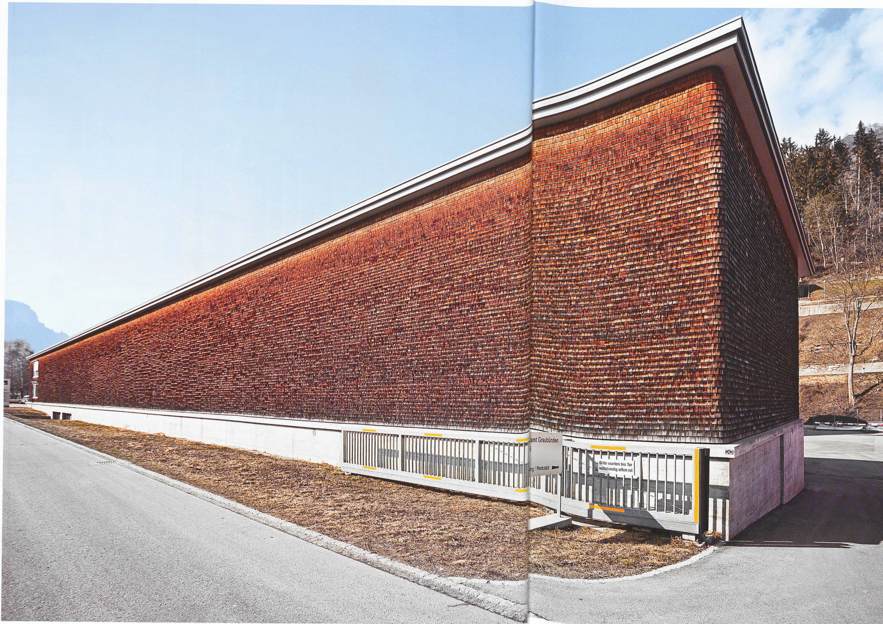
Werkhof aus Holz in Itanz: 150'000 Schindeln aus Gebirgsläuche auf einer Wandfläche von 1500 m 2 . Architektur: Albertin&Zoanni, Chur, 2003 (links) Werkhof aus Holz in Flums: Architektur: Schlegel-Engler, Buchs, 2009 (rechts)
