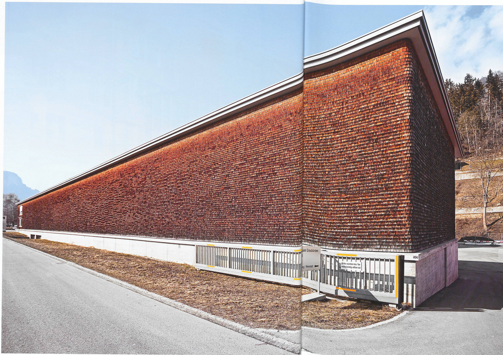
Werkhof aus Holz in Ilanz: 150'000 Schindeln aus Gebirgslärche auf einer Wandfläche von 1500 m 2 . Architektur: Albertin&Zoanni, Chur, 2003 (links) Werkhof aus Holz in Flums: Architektur: Schlegel-Engler, Buchs, 2009 (rechts)
