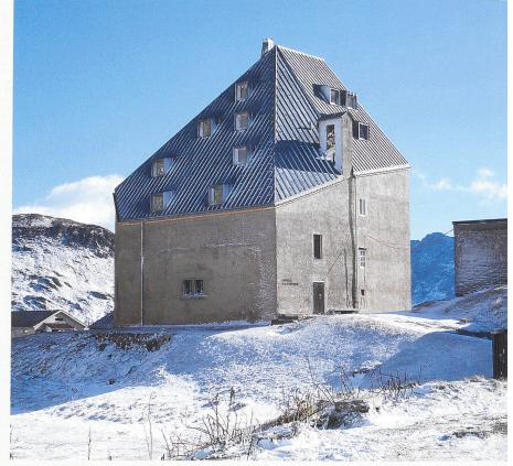
Gotthard-Hospiz: eine tragende Holzkonstruktion im Gebäudeinneren, Fassade und Treppenhaus in Massivbauweise
