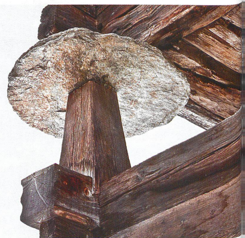
Mühlebach: Die Stützen heben sich vom Boden ab, damit Getreide und Hausrat vor Feuchtigkeit geschützt sind, die Steinplatte dient als Schutz vor Nagetieren
