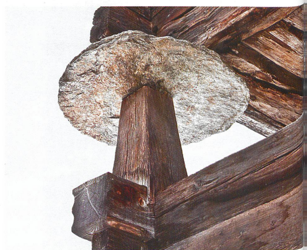
Mühlebach: Die Stützen heben sich vom Boden ab, damit Getreide und Hausrat vor Feuchtigkeit geschützt sind, die Steinplatte dient als Schutz vor Nagetieren
