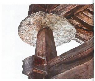
Mühlebach: Die Stützen heben sich vom Boden ab, damit Getreide und Hausrat vor Feuchtigkeit geschützt sind, die Steinplatte dient als Schutz vor Nagetieren
