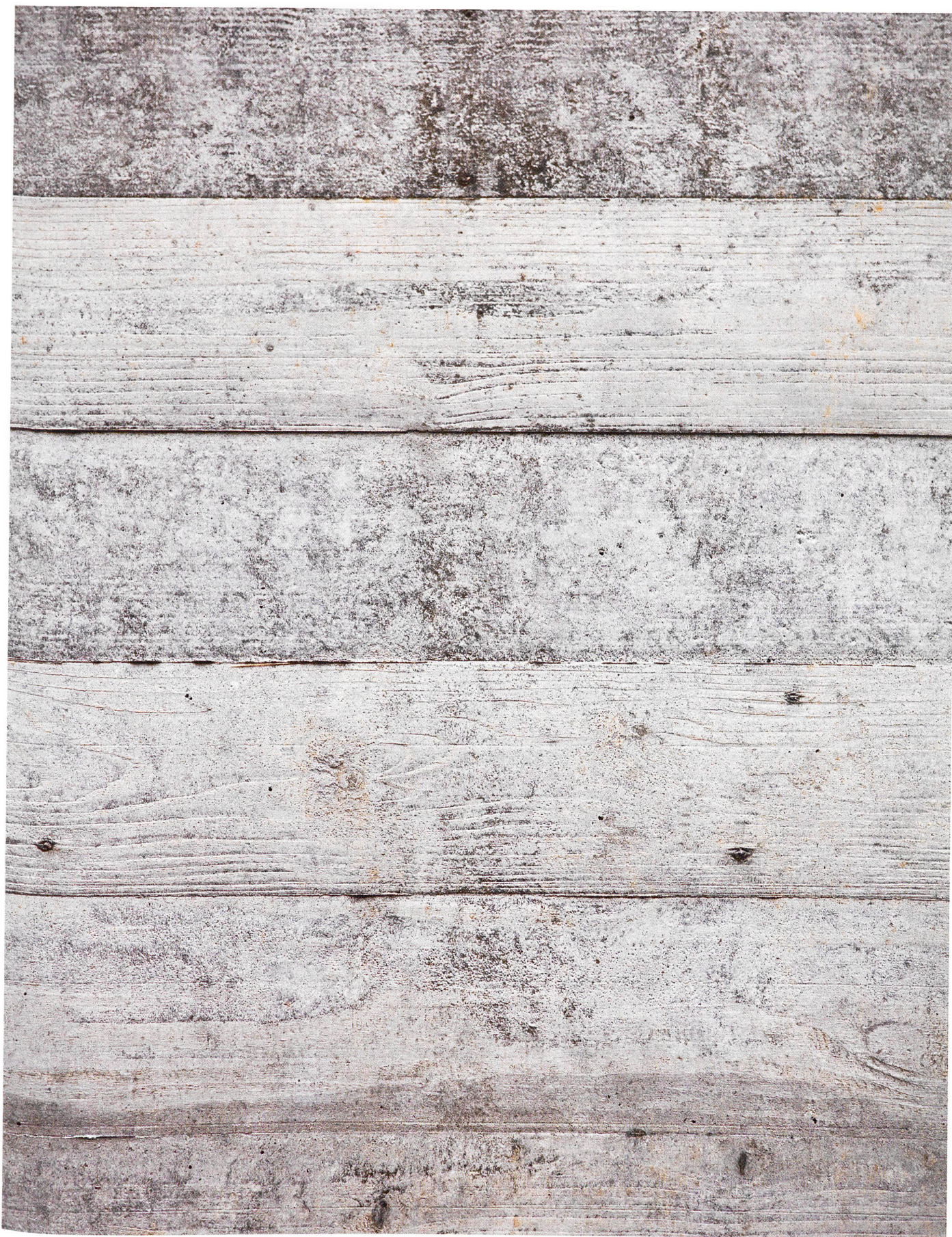
Schalungsbild: Alles, was am Sichtbeton noch feststellbar ist, sind «Fingerabdrücke» des Holzes
