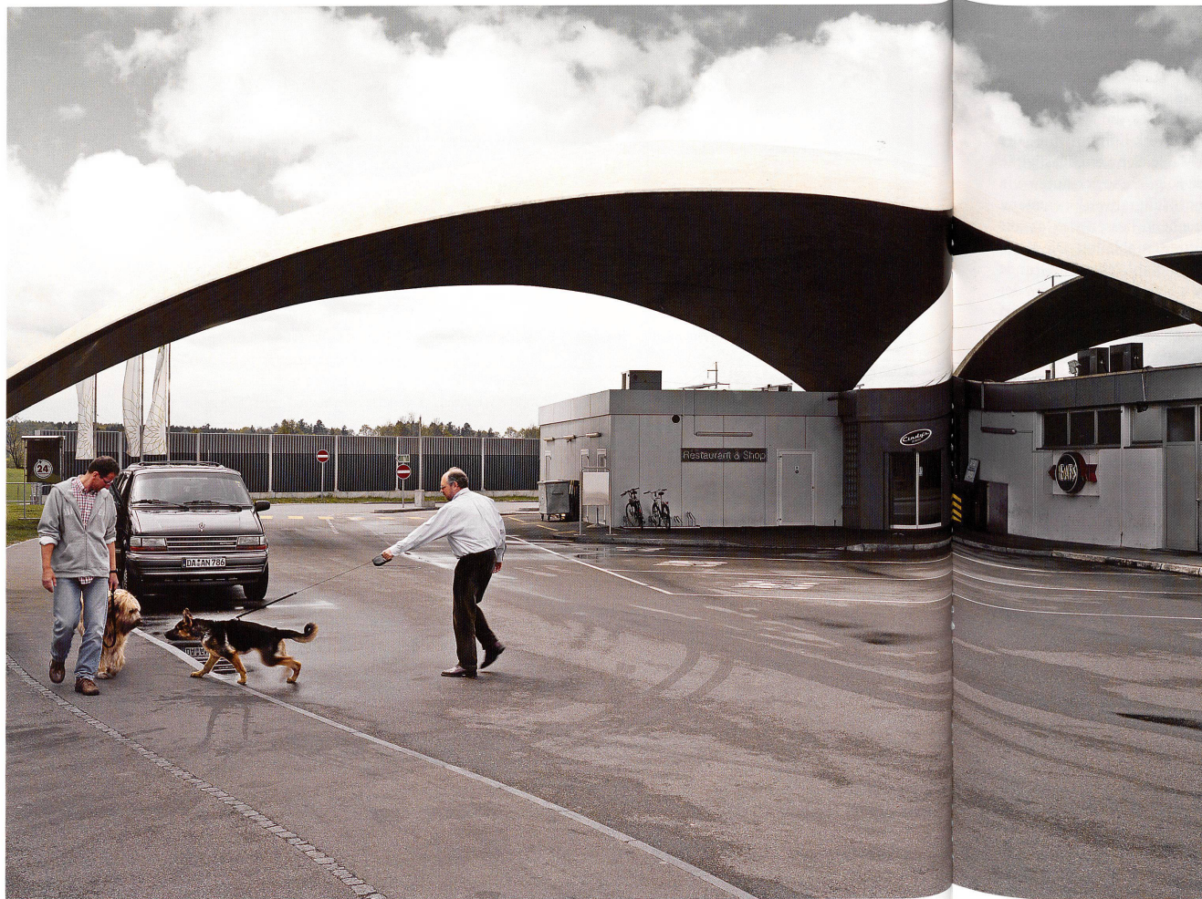
Isler-Schalen: 15 cm dicke Stahlbetonschalen in Deitingen-Süd, erbaut 1968 (aus der Serie «Menschen vor Ort» von Valentin Jeck)
