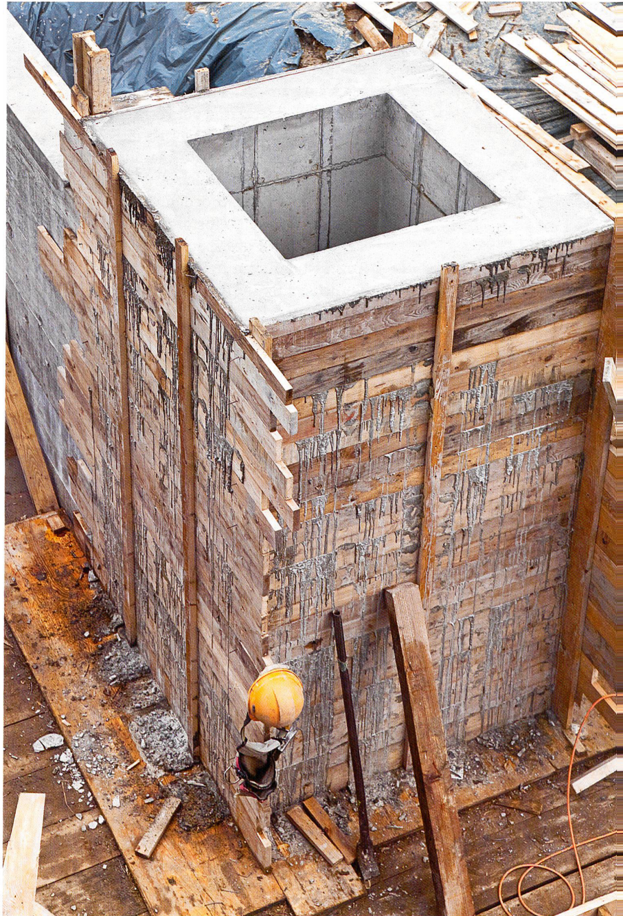
Betonwerk: Im Inneren schlummert das cartesianische Netzwerk der Armierung
