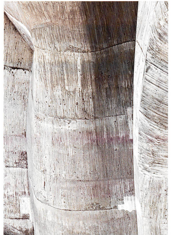
Betonplastik: Schalungsbild am Goetheanum
