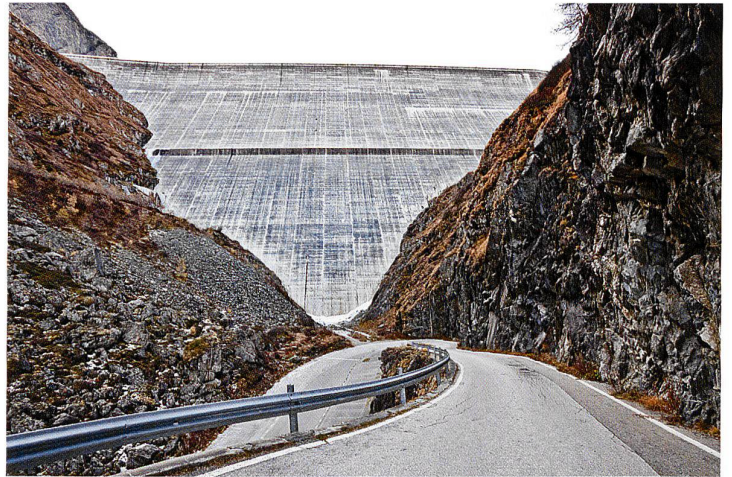
Energie-Kathedrale: die Staumauer Grande Dixence aus 6 Millionen Tonnen Beton, siehe Seiten 50 / 51
