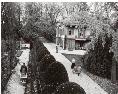
Chambésy-Dessous, La Malvande, état vers 1900, collection particulière.
