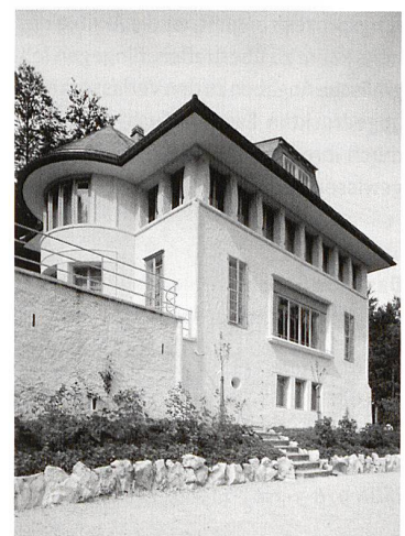
La Chaux-de-Fonds, Maison Blanche von Le Corbusier. (Repro, S. 95; Eveline Perroud, 2006)
