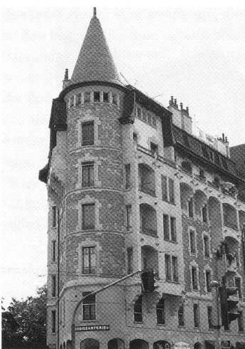
Genève, immeuble de logements, rue de Saint-Jean 56–58, angle chemin du Ravin, 1909 (© 2003 Mélanie Delaune, Genève)
