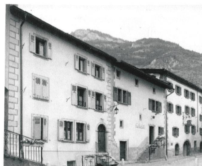
Saillon, maisons d'habitation. (Service des bâtiments, monuments et archéologie de l'Etat, Protection des biens culturels, Sion; Bernard Dubuis)
