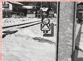
Gleisachsversicherung Vérification de l'axe d'une voie ferrée
