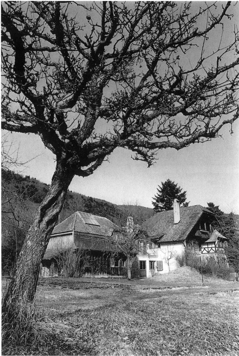
12 Orvin, Landsitz Le Jorat, erbaut von und für Léo-Paul Robert 1907–08. – Die Gebäudegruppe wirkt wie eine Kopie des Unteren Rieds (Abb. 11), nur sind die Funktionen vertauscht: Das Haus im Vordergrund beherbergt im Unteren Ried die Wohnungen, im Jorat das Atelier mit der gleichen Oberlicht-Lösung wie bei Roberts grossem Atelier im Ried.
