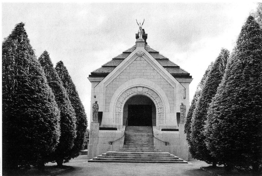
Porche d'entrée du crématoire de La Chaux-de-Fonds (façade nord-est).
