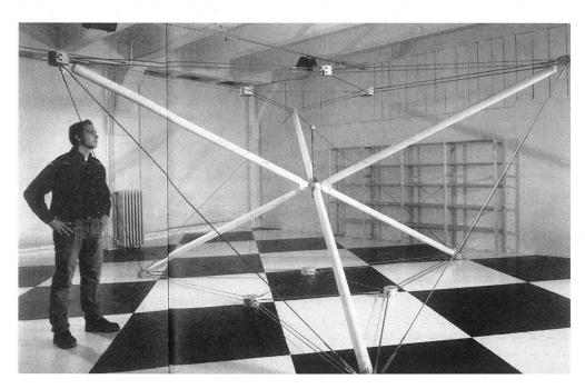
4 Direction technique der Expo.01, Tensegrity, 1998. – Das flexible Tensegrity-System wird seit den 1960er Jahren wegen seiner Leichtigkeit und Vielseitigkeit geschätzt. Es ist ständig weiterentwickelt worden und hätte als Baumaterial für die Arteplages verwendet werden sollen.
