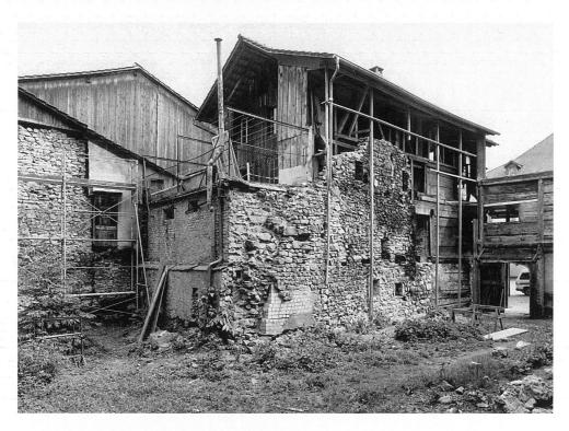
7 Unterseen, Ostabschluss. Die Nordseite des Hauses Kirchgasse 11 zeigt den unmittelbaren Wechsel zwischen Holz- und Steinbau. Der Sockel des Holzbaus rechts ist dendrochronologisch ins Jahr 1495 datiert. Die daran anschliessende Mauer ist nachweislich gleichzeitig entstanden.
