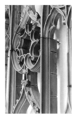
8 Basel, Kleiner Münsterkreuzgang, Euphrosynegrab, Detail. – Gut sichtbar sind die Nuten, in die zur Sicherung des Grabes einst eiserne Lamellen eingelassen waren.
