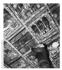
Zillis, St. Martin, Probenentnahme für die dendrochronologische Datierung aus einem Dachbalken über der romanischen Bilderdecke.
