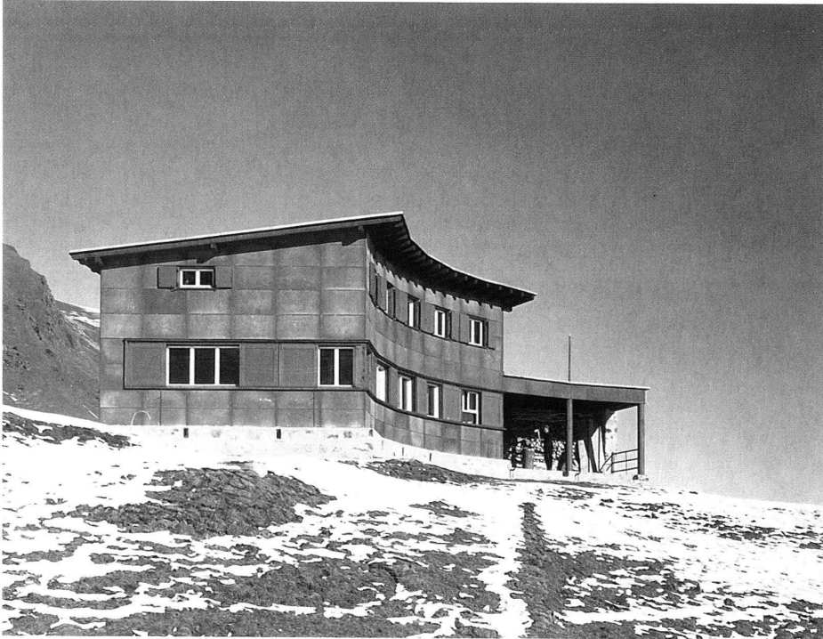
Braunwald-Alp, Sporthaus Ortstock, Architekt Hans Leuzinger, 1931, Ansicht von Südwesten.
