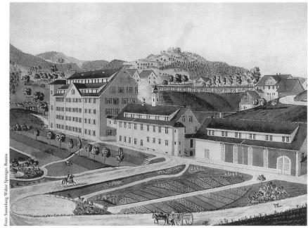
Ansicht des Neuthal-Ensembles Mitte der 1840er Jahre, mit Fabrik, Fabrikantenhaus und Ökonomiegebäude. Im Hintergrund ist der auf Holtstützen geführte neue Zulaufkanal zum Wasserradhaus erkennbar. Rechts oben die ehemalige Mühle Müedsbach, vorne die ausgedehnte Parkanlage.
