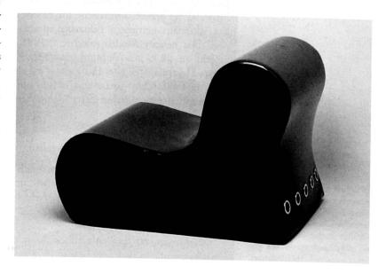
7 Haus, um 1970, Entwurf: Franz Dutler, Organchemie AG, Kilchberg. – Das Polyester-Haus, mit einer im Wickelverfahren hergestellten Aussen- und Innenschale, ging einen Schritt weiter als die bis anhin bekannten Kunststoff-Häuser in Element-Bauweise.
