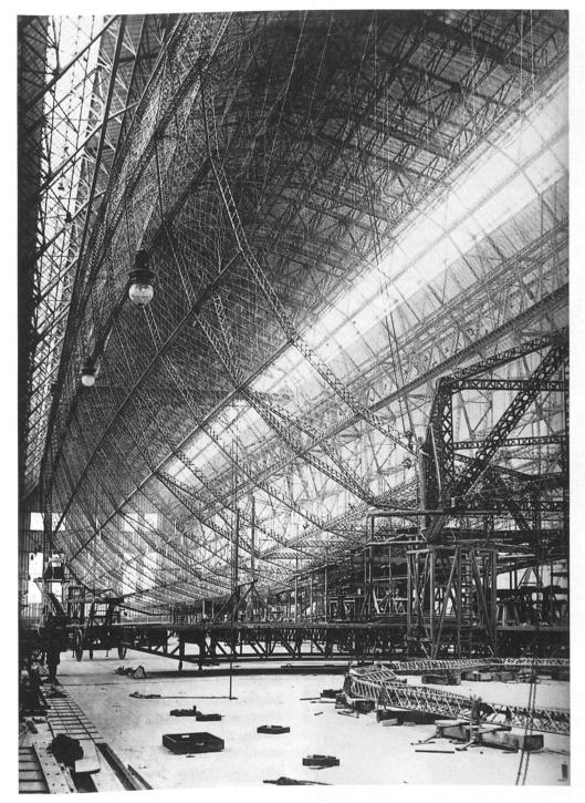
4 Gerippe eines Zeppelin-Luftschiffes aus Aluminium-Profilen, Aufnahme 1931. – Der Luftfahrt verhalf das Leichtmetall in formaler und konstruktiver Hinsicht zum Durchbruch. Die militärische Aufrüstung verschlang riesige Mengen an Aluminium und trug gleichzeitig zur Erprobung industrieller Fertigungen bei.
