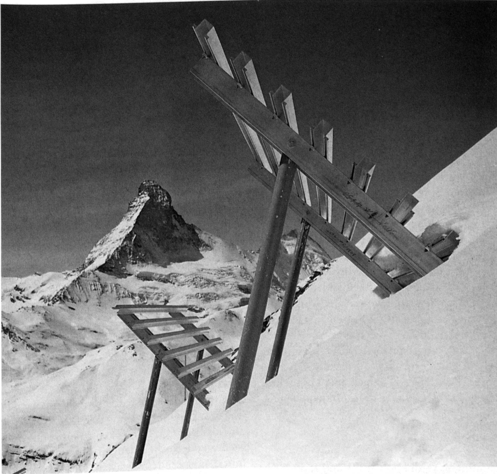
2 Lawinenverbauungen aus Aluminiumprofilen bei Zermatt. – Die Tatsache, dass Aluminium neben Holz der einzige Rohstoff ist, den die Schweiz selbst herstellt, hat ihm den Mythos des Schweizerischen Metalls eingebracht.
