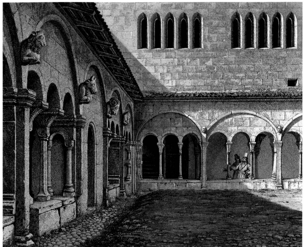
1 und 2 Zürich, Grossmünster, Kreuzgang (um 1170–1180), Ansicht des Kreuzgangs vom Garten aus und Blick in den West- und Südflügel vom Durchgang zwischen Chor und Kreuzgang her. – Die Aquatinta-Blätter von Franz Hegi, vor 1840, zeigen den Kreuzgang vor seiner Rekonstruktion.
