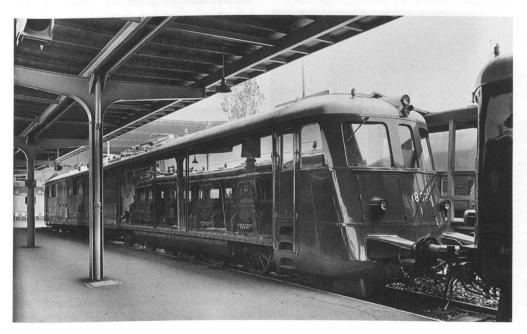
7 Die «Landi»-Lokomotive mit durchsichtigen Seitenwänden. – An der Ausstellung waren die Seitenteile auf einer Seite mit Glasscheiben ersetzt worden. Dies erlaubte einen Blick in den imposanten Maschinenraum mit den je zwei Motoren für die insgesamt 8 Antriebsachsen.
