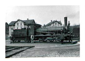
vorrat, der durch Rohre unter die Räder geblasen wurde, wenn die Schienen glatt waren. Auch das Sicherheitsventil war oft sichtbar angeordnet (Abb. 5).
