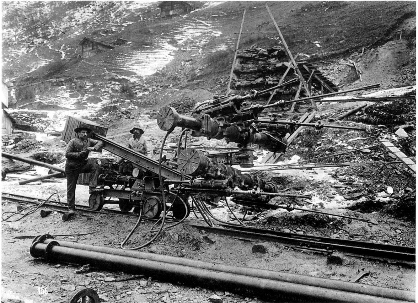
Schienenfahrzeug mit Bohrvorrichtung für fünf Löcher. Gelatinesilberkopie auf Papier, matt, 18,9×22,3 cm (Sammlung Herzog, Schweizerisches Landesmuseum Zürich, LM100178.20).
