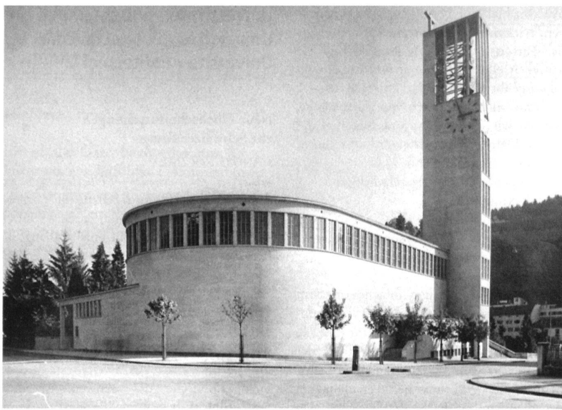
Luzern, St. Karl, Fritz Metzger, 1932–34, Sakristei­flügel, Chor und Turm von Nordwesten, 1934.
