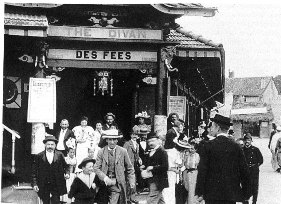
1 Parc de Plaisance de l'Exposition nationale, Genève 1896: façade principale du Palais des Fées, telle qu'elle apparaît dans le film Lumière n° 310, «Cortège arabe». L'attraction principale, annoncée par les affiches (visibles sur les piliers) et par un panneau sur le second pignon (hors champ), en était le Cinématographe Lumière. Son concessionnaire, Lavanchy-Clarke, figure à l'image; c'est l'homme qui s'approche en tenant un enfant par la main. Copie d'un photogramme d'un tirage 35 mm moderne du film.
