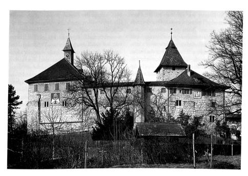
9 Die Kyburg von Südosten, 1972. Die Renovation von 1925 ff. hat das Mauerwerk sichtbar gemacht und vor allem Umbauten im Bereich des Bergfrieds, des Mehrzweckgebäudes und des südlichen Wehrgangs gebracht.
