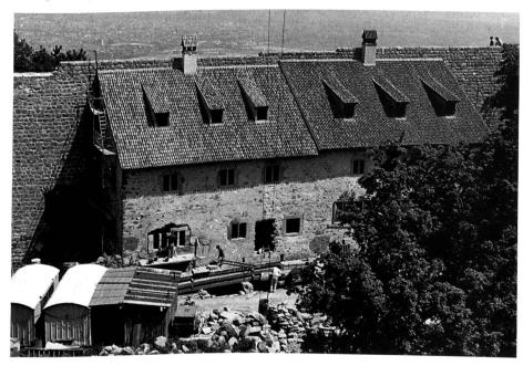
9 Vue d'ensemble des logis Schwendi et Lupfen adossés à la grande enceinte côté Est. A remarquer les toitures avec couvertures en tuiles canal, copies des modèles du XIII siècle retrouvés en fouilles. Situation juillet 1905
