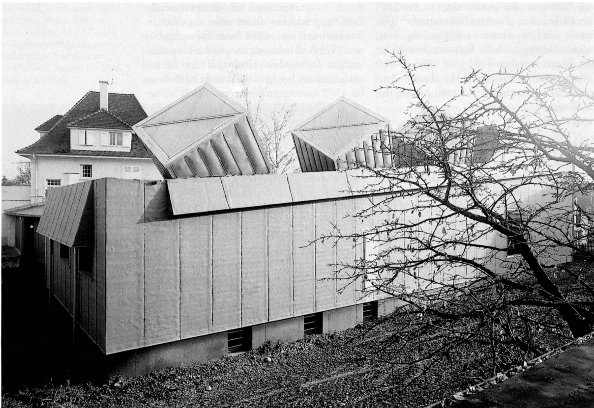
3 Weil am Rhein (D), Photostudio Frei, Projekt 1981, Ausführung 1982. – Der Anbau an eine Gründerzeitvilla mit seinen drei immensen Oberlichtern ist mit Sperrholzplatten und Dachpappe verkleidet.
