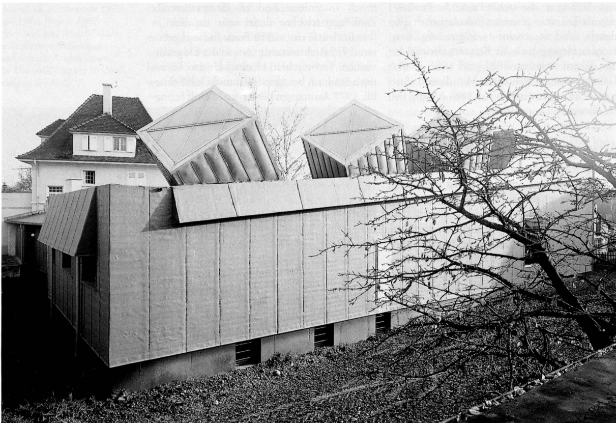
3 Weil am Rhein (D), Photostudio Frei, Projekt 1981, Ausführung 1982. – Der Anbau an eine Gründerzeitvilla mit seinen drei immensen Oberlichtern ist mit Sperrholzplatten und Dachpappe verkleidet.
