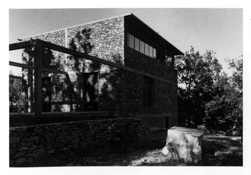
4 Tavole (I), Steinhaus, Projekt 1982, Ausführung 1985/88.— Das Betonskelett, im Inneren kreuzförmig angelegt, ist aussen mit Bruchsteinen der Umgebung ausgefüllt.
