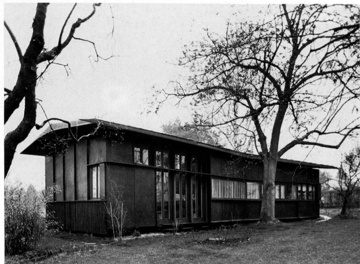
5 Bottmingen, Sperrholzhaus, Projekt 1984, Ausführung 1985. – Das Marionettentheater, wie ein Resonanzkasten innen und aussen mit Holz verkleidet, scheint wie ein hermetisches Objekt seine Umgebung kaum zu berühren.
