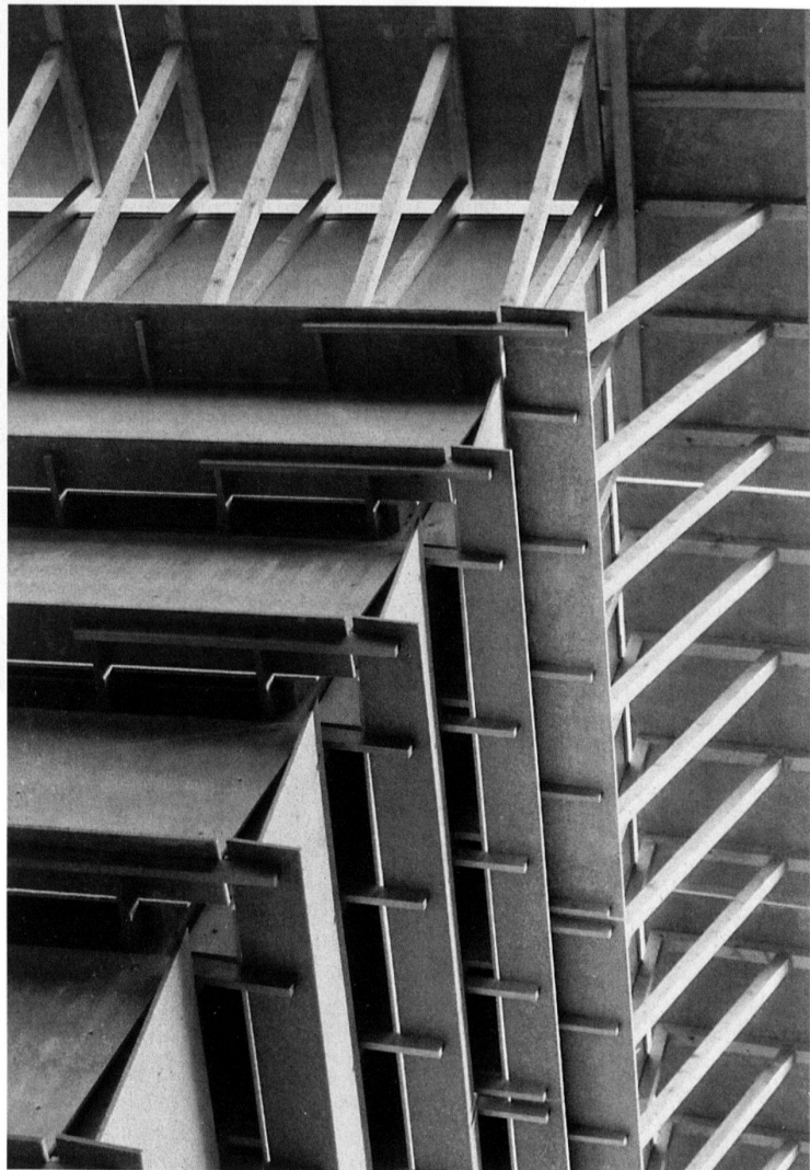
7a+b Laufen, Lagerhaus Rico-la, Projekt 1986, Ausführung 1987. – Die übereinandergeschichteten, nach oben breiter werdenden Eternitplatten der Verkleidung des Hochregallagers erinnern an Bretterstapel.
