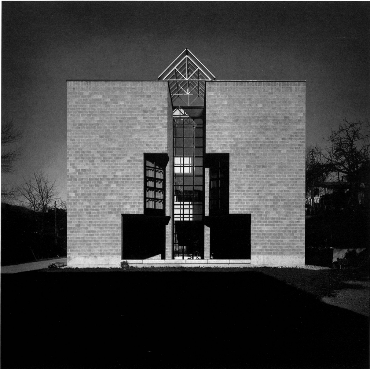
7 Das Licht: Einfamilienhaus in Pregassona, 1980. – Lichtführung, nicht Beleuchtung: Bottas Häuser sind zum Himmel hin offen.
