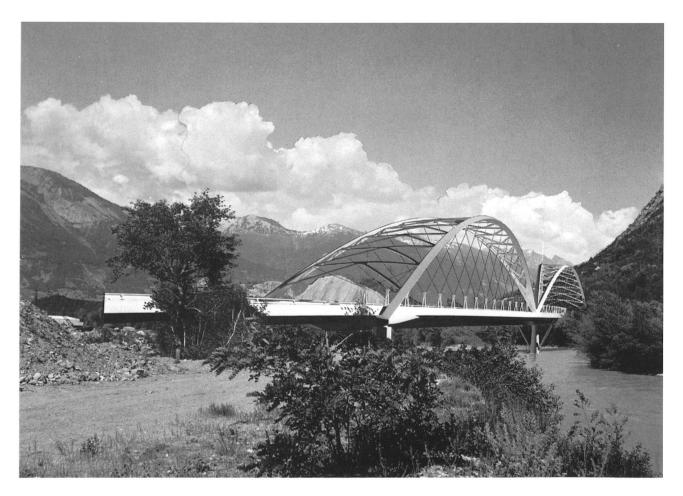
11 Sierre, Ile-de-Falcon-Brükke, Wettbewerbsprojekt, Fotomontage, Santiago Calatrava, 1993. – Spielerisch-effektvolle Projekte sind in der Schweiz sehr schwer durchzusetzen. Die Tragkonstruktion ist aus Stahlbeton, der Überbau aus Stahl.
