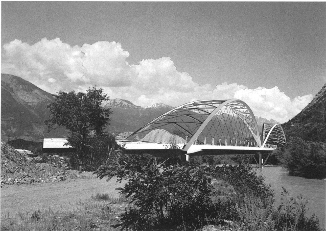
11 Sierre, Ile-de-Falcon-Brücke, Wettbewerbsprojekt, Fotomontage, Santiago Calatrava, 1993. – Spielerisch-effektvolle Projekte sind in der Schweiz sehr schwer durchzusetzen. Die Tragkonstruktion ist aus Stahlbeton, der Überbau aus Stahl.
