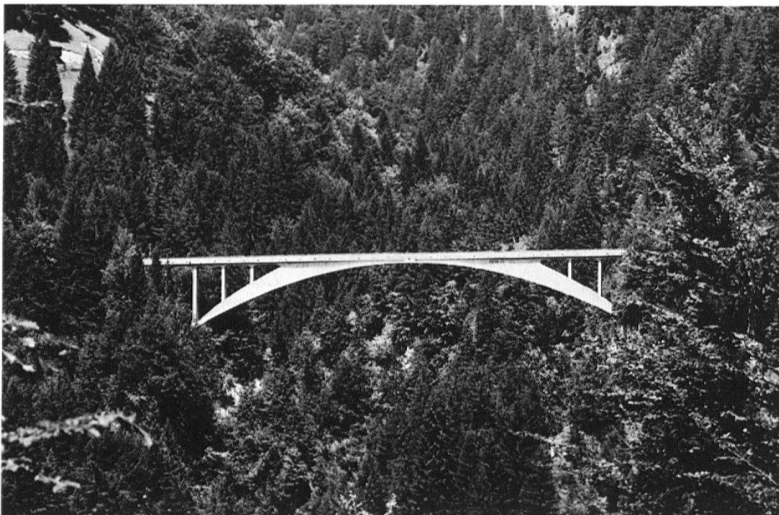
2 Schiers, Salginatobelbrücke, Ansicht, Robert Maillart, 1929–1930. – Heute noch faszinierend: Die kühne Konstruktion, nicht zuletzt auch wegen ihrer geringen Breite von 3,8 m, gehört zu den bemerkenswertesten Brückenbauten in Stahlbeton. Aufnahme 1989.
