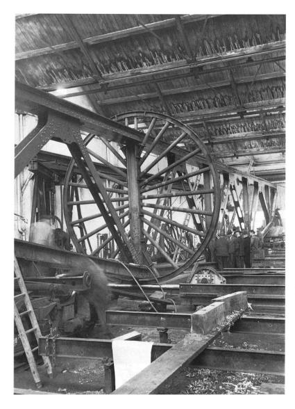
10 Die Thurbrücke bei Ulisbach im Toggenburg war die erste teilgeschweisste SBB-Brücke. Um das Überkopfschweissen zu vermeiden, montierte man die Brückenträger auf ein Drehrad. 1945, W. Erni, Brückenmonteur.
