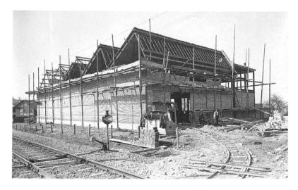
5 Bau der ersten Etappe der Eisenbauwerkstätte in Kloten. Es war für den Firmengründer Karl Löhle selbstverständlich, dass er in der eigenen Fabrik seine selber erfundenen Sheddächerkonstruktion anwandte. Ca. 1902.
