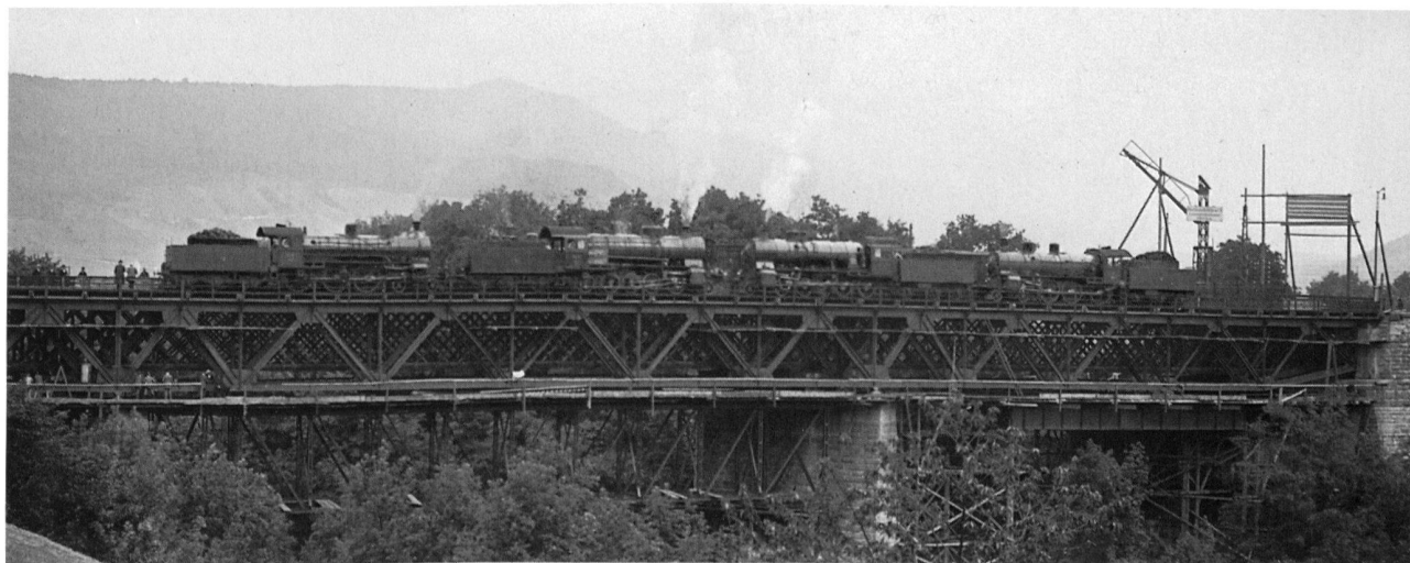
4 Belastungsprobe der Limmatbrücke 1922, hinter der neuen Brücke ist die ausgeschobene alte noch sichtbar.
