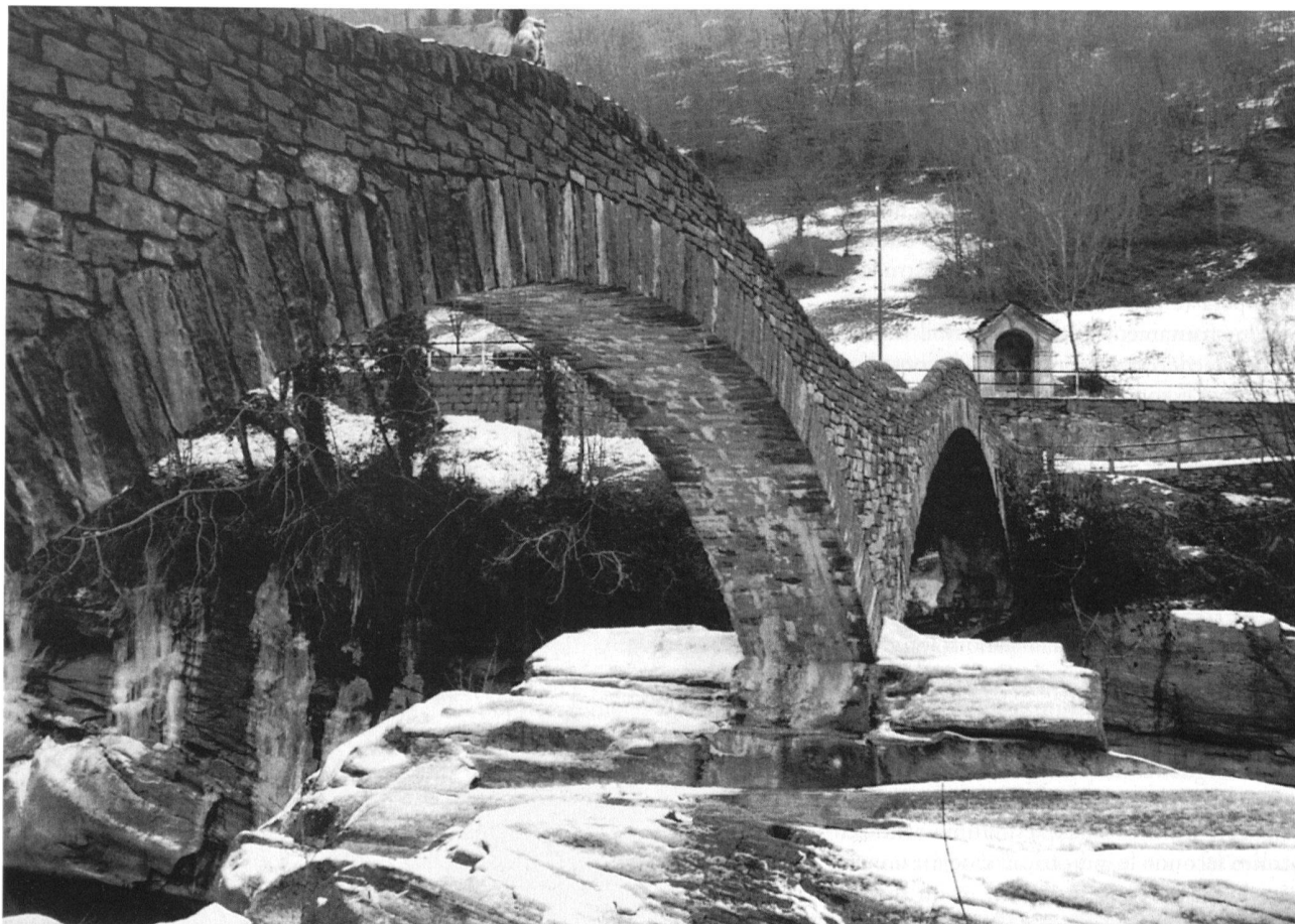
3 Il Ponte dei Salti di Lavertezzo, caratterizzato dall'armoniosa sequenza dei due archi. In primo piano l'arco di destra di più recente costruzione.
