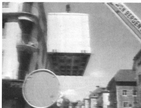
Ein Pneu Kran setzt den Container «Video Communication» auf der Strasse ab
