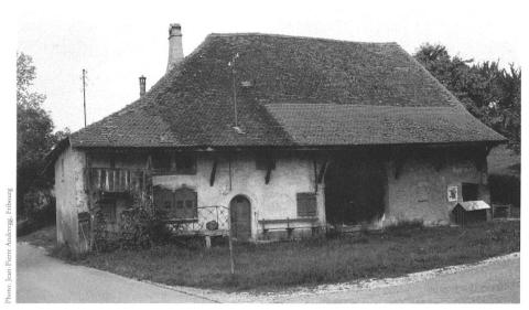
Châtillon FR, ferme double nº 14/15 avant la démolition, fassade est du bâtiment nº 15. – A gauche, l'extension du bâtiment abrite un four; à droite, on observe une porte à linteau cintré en partie murée.
