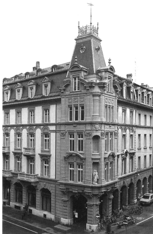
6 Die Fassaden des 1904 von Otto Lutstorferbauten Siplon-Hauses an der Ecke Aarberggasse/Genfergasse wurden jahrzehntelang vernachlässigt. Mitte der siebziger Jahre wurden die Fassaden durch Beseitigung der Dachzier und der Bauplastik verstümmelt. Die 1990–93 durchgeführte Fassadenrenovation hat dem prominenten Eckgebäude seinen Charakter wiedergegeben.
