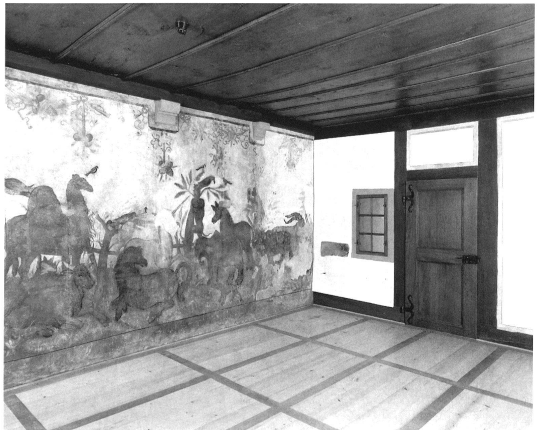
3 Im Hofzimmer des 3. Obergeschosses wurde an der Marktgasse 61 unter einer Vertäfelung des 18. Jh. die rund 100 Jahre ältere Raumgestaltung aufgedeckt. Die gut erhaltene, einzigartige Wandmalerei mit einheimischen und exotischen Tierdarstellungen wurde lediglich gereinigt und retuschiert.
