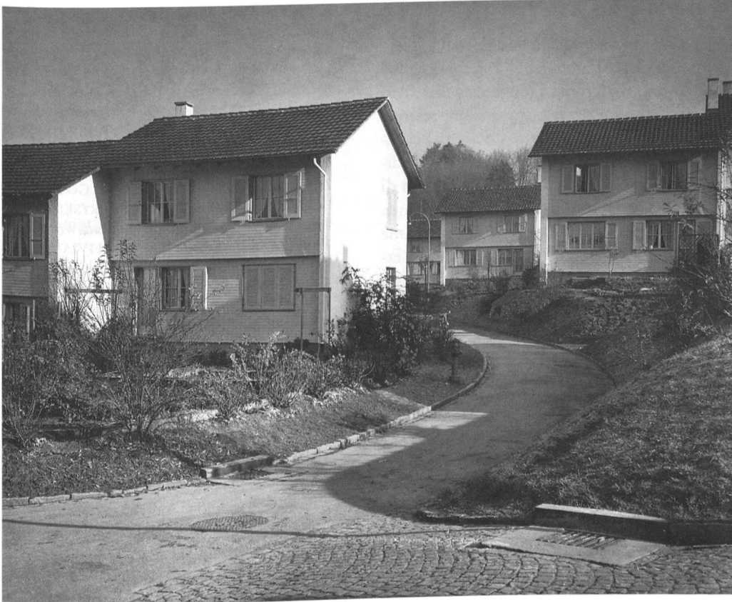
5 Die Siedlung Hohllebi als Beispiel eines Inventarobjektes der Nachkriegszeit. Die Anlage wurde von Walter Schwaar im Rahmen des kommunalen Wohnungsbaus 1946–48 erbaut. Die an einem Nordhang gelegenen Häuser sind in Dreier- und Vierergruppen mit versetzten Grundrissen angeordnet. Die kurz nach der Fertigstellung aufgenommene Foto macht die räumlich interessanten Aussenbereiche sichtbar. Im Entwurf zum Quartierinventar Bümpliz 1993 ist die Siedlung, die 1988 sorgfältig renoviert wurde, im Situationswert als «schutzwürdig» eingestuft.
