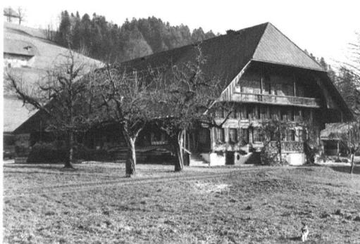
15 Langnau, Obere Habegg, prächtiges Bauernhaus Nr. 866 von 1850, Stallteil jünger. Ständerbau mit Einzelbefensterung, auf älterem Sockel. In Gestaltung und Dekoration typische Fassade. Die Ründi setzt sich im Emmental erst im 19. Jh. allmählich durch; bis um 1850 werden noch ans 18. Jh. gemahnende Holzbauten mit mächtigen Dreiviertelwalmdächern gebaut.
