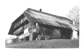
3 Eggiwil, Gustichnubel, Bauernhaus Nr. 137 von 1649, spätere Erweiterungen. Wohn- und Ökonomieteil unter dem gleichen Dach. Erdgeschoss Ständer-, Obergeschoss teilweise Blockbau. Um 1760 neue, steilere Dachkonstruktion zur Vergrösserung des Dachraumes. Giebelseitig keine ausformulierte Fassade, Haupterschliessung traufseitig.
