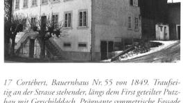
bau mit Gerschilddach. Prägnante symmetrische Fassade mit sieben Achsen, eleganten hochrechteckigen Fenstern und zweiläufiger Freitreppe. Foto 1973.
