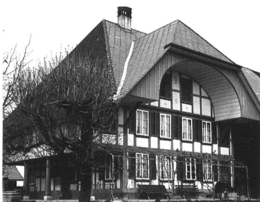
18 Büren zum Hof, Limpachstrasse 6. Stattliches Bauernhaus von 1851, Riegkonstruktion, Quergiebel, säulengestützte Laube. Im tieferen Mittelland und im Schwarzenburgerland, wo die traufseitige Orientierung eine alte Tradition hat, finden Quergiebel im 19. und 20. Jh. grosse Verbreitung. Foto 1970.
