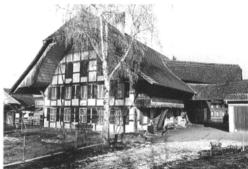
16 Oberwichtlach, Hängertstrasse 6, stattliches Bauernhaus wohl von 1847. Weitgehend unveränderter Riegbau. Diese holzsparende Gemischtbauweise setzt sich erst im 19. Jh. in einem breiteren Gebiet durch. Bis um 1900 wird im Aare- und Emmental und im Seeland der traditionelle, reine Holzbau fast gänzlich verdrängt.
