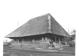
11 Iffwil, Taunerhaus mit zwei Wohnteilen, Moosgasse 24, um 1750. Vollwalmdach mit vier Hochstüden. Im tieferen Mittelland sind diese Form und diese Konstruktion des Daches bei Bauernhäusern bis ins frühe 19. Jh. vorherrschend. Hochstuddächer kommen bis an eine südliche Grenzlinie Bowil–Uetendorf vor. Renovationsarbeiten 1983/88.
