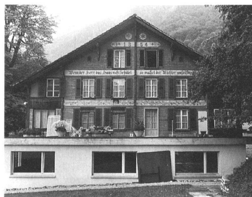
14 Oberried am Brienzersee, Wohn- und Gewerbehaus Nr. 160 von 1854. Der sauber ausgeführte, vollsymmetrische Blockbau trägt mit seinem steileren Dach und einzelnen Elementen des Dekors bereits Züge des Schweizer Holzstils. Dagegen lebt in den hell unterlegten Schrift- und Friesfeldern eine Tradition des späten 18. Jh. weiter. Massive Veränderungen im Sockelbereich.
