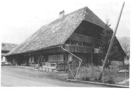
4 Riggisberg, Vordere Gasse 14/16, stattliches Bauernhaus, erbaut 1663, spätere Erweiterungen. Wichtiger, trausseitig orientierter Ständerbau. Im Dach Kombination von Hochstud- und liegender Dachstuhlkonstruktion. Das Haus vereinigt auf interessante Weise Elemente der Mittelländer und Schwarzenburger Bautradition. Reicher Dekor.
