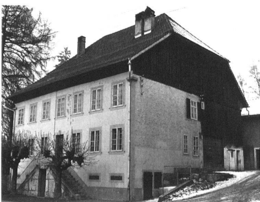
17 Cortébert, Bauernhaus Nr. 55 von 1849. Traufseitig an der Strasse stehender, längs dem First geteilter Putzbau mit Gerschilddach. Prägnante symmetrische Fassade mit sieben Achsen, eleganten hochrechteckigen Fenstern und zweiläufiger Freitreppe. Foto 1973.
